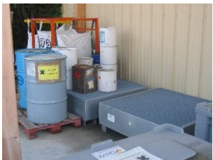
Bacs de rétention
