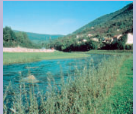
Les travaux de renaturation réalisés sur l'Albarine (Argis, Ain) font référence en Rhône-Alpes.
