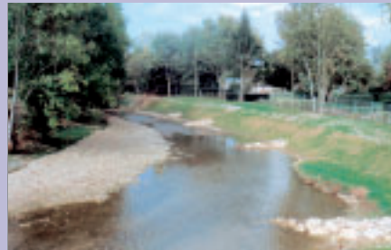
Création d'épis en enrochements et protection de la berge de la Brenne.
